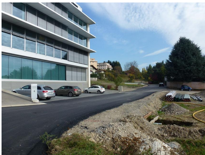
Pose d'un enrobé provisoire au chemin de Bérée dans l'attente des futurs chantiers du quartier des Fiches nord.
