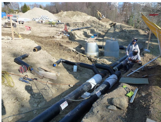
Soudure des tubes de chauffage à distance
