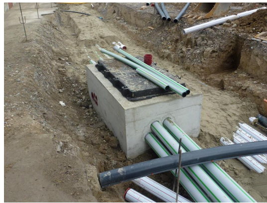
Création de chambre de tirage (Swisscom, Multimédia)
