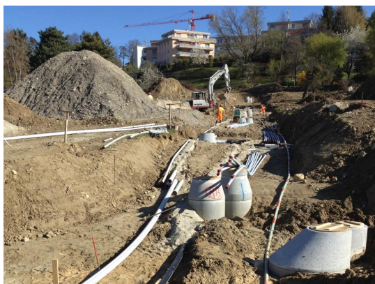
Pose des services (Swisscom, SEL, Multimédia, Eau, CAD)
