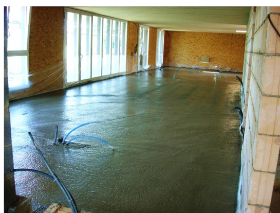
Pose de la chape
