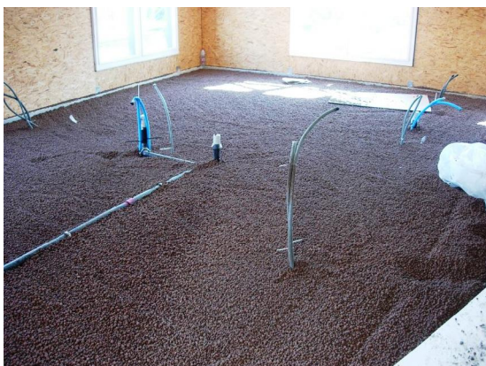
Chape allégée avec des billes d'argiles expansées
