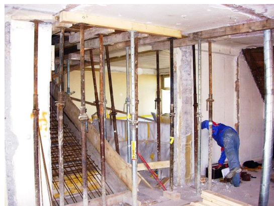
Création de la nouvelle trémie d'escalier
