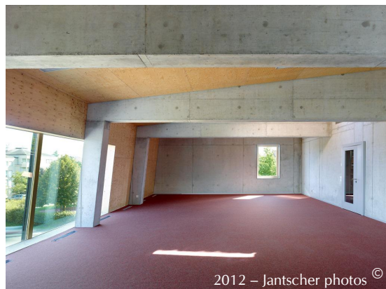
Sommiers précontraints de toiture
